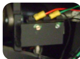
1 resistência de 25W no micro do freio(2)
